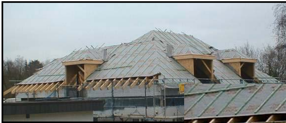
Unterspannbahn inkl. Konterlattung
