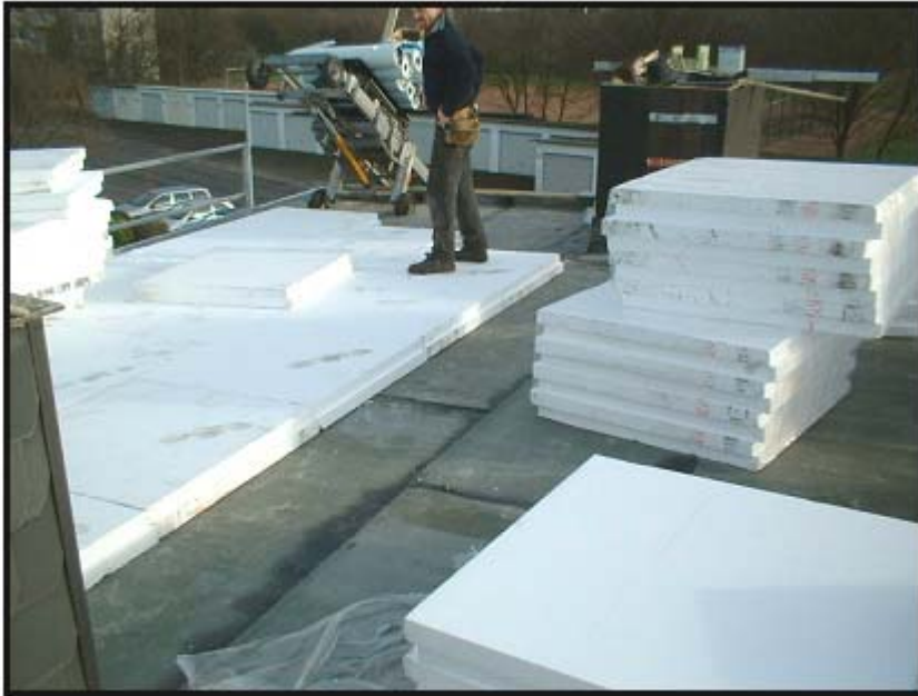
Wärmedämmung aufkleben
